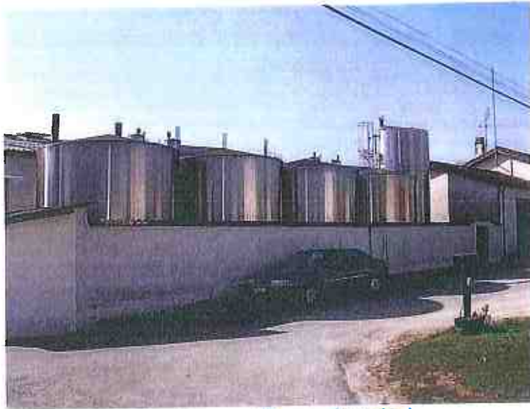
Figure 10 : Zone N°3 de stockage de vin
