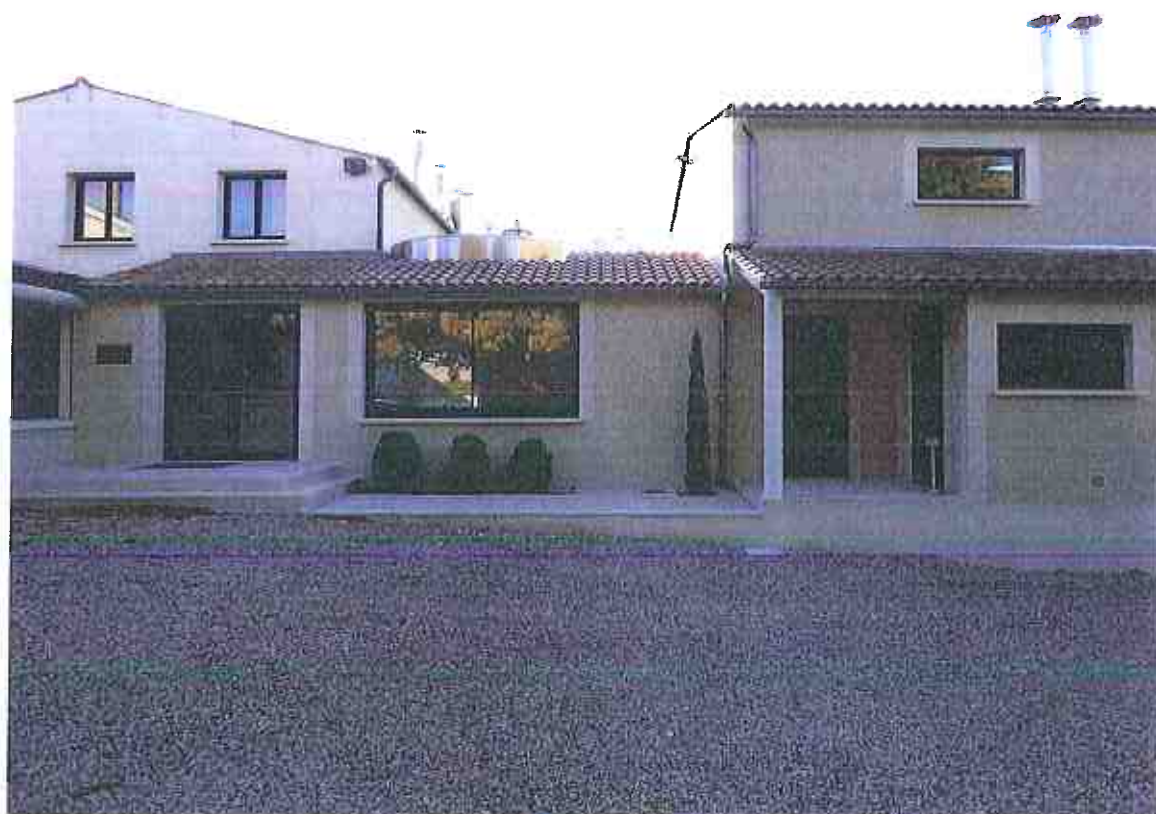
Figure 5 : Vue de l'entrée des locaux administratifs
